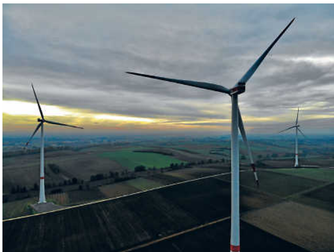
Klima- und Umweltschutz Windpark
